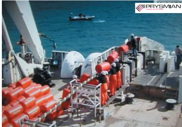
**Colocación de boyas en el cable según se va tendiendo éste sobre la superficie del mar**
